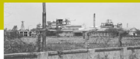
**Descripción:** El evento se inicia a consecuencia de unas tareas de limpieza rutinarias de un depósito que contiene unas 30 toneladas de metil isocianato. Se produce un escape que genera una nube de vapor que se desplaza a barrios marginales densamente poblados y próximos a la planta.
