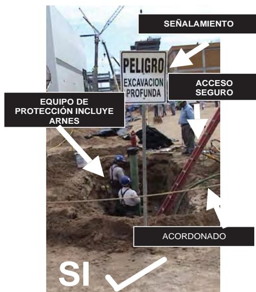
o cualquier método de estabilización de los taludes y/o paredes de la zanja de igual manera tratándose de suelos, incluir en las paredes y taludes.
