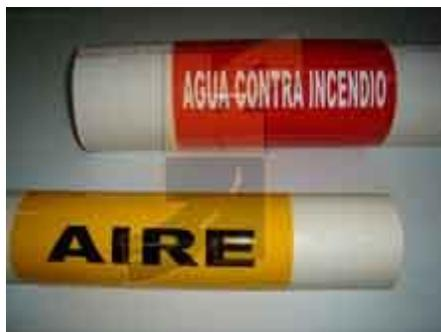
Para tuberías con diámetro mayor a 300 mm., la altura mínima de las letras será de 15 cm., y la máxima igual al valor obtenido en la ecuación. Y si la tubería tiene un diámetro menor a 25 mm., se debe utilizar una placa, siendo la altura del texto como mínimo 10 mm.
