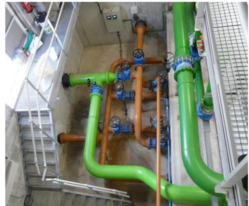
O bien, si detectas que una tubería que conduce aire a una presión mayor a  $7\text{kg/cm}^2$  y está pintada de color verde, pues el patrón cree que el aire es inofensivo, debes informarle que está incumpliendo la **NOM-026-STPS-2008** debido a que el fluido está a una presión manométrica extrema, lo cual lo convierte en peligroso y por ende debe pintar dicha tubería de amarillo.
