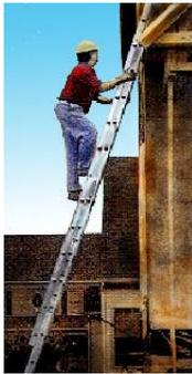
Las **escalas móviles**, como lo determina su nombre, pueden ser transportadas (portátiles), instaladas y removibles en poco tiempo. Las más comunes son las escalas verticales, como las usadas para acceder a una parte alta de un muro y las cuales se recargan usualmente en el mismo, y las escalas de tijera, que se abren para prescindir de un muro donde recargarlas, éstas son usadas por lo general para acceder a techos o a estantes en donde no es recomendable recargar una escala vertical.
