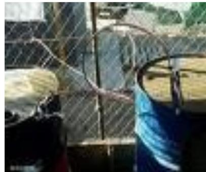
b) En las zonas en donde se manejen, almacenen o transporten sustancias inflamables o explosivas, deben conectarse a tierra las partes metálicas que no estén destinadas a conducir energía eléctrica, tales como cercas perimetrales, estructuras metálicas, tanques metálicos, cajas metálicas de equipos y maquinaria o tuberías (excepto las de gas).
